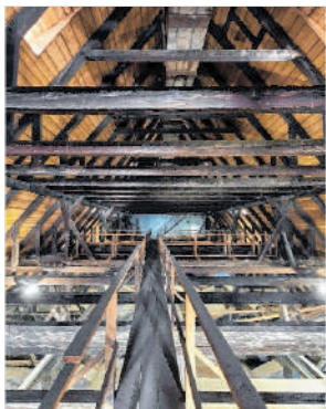
Der Dachstuhl der Hofkirche wird für Besucher geöffnet.
